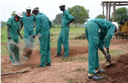
Abbildung 6: Erde wird zur Herstellung der Ziegel gesiebt
